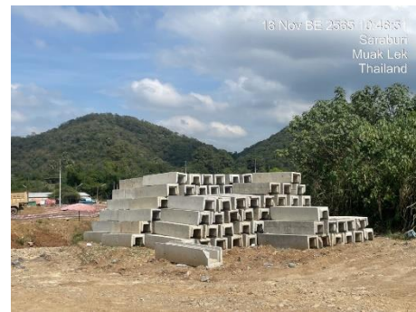
ภาพที่ 2.2-59 การใช้ชิ้นส่วนหล่อสำเร็จในงานก่อสร้าง
