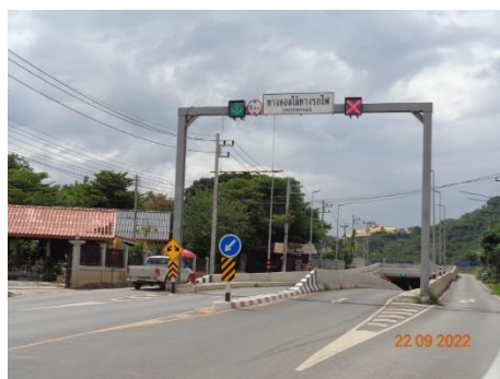
ภาพที่ 2.2-15 การติดตั้งไฟส่องสว่างและติดตั้งป้ายบอกระดับความสูงบริเวณทางลอดชุมชน
