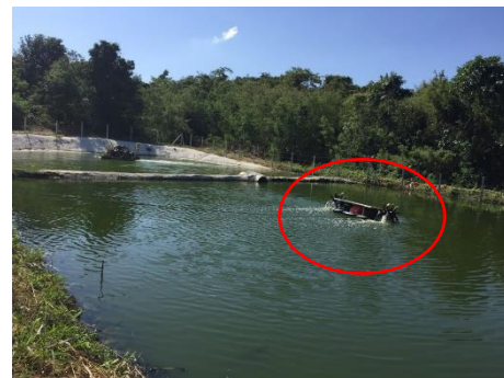
การติดตั้งเครื่องเติมอากาศ (Aerator) บริเวณบ่อพักน้ำสุดท้าย
