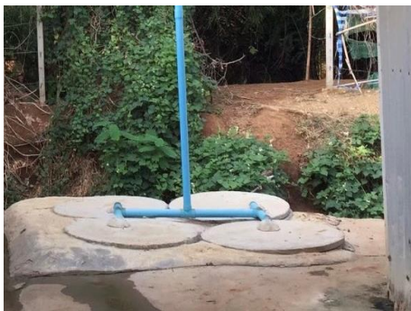
ภาพที่ 2.2-17 ระบบบำบัดน้ำเสียบริเวณบ้านพักคนงาน
