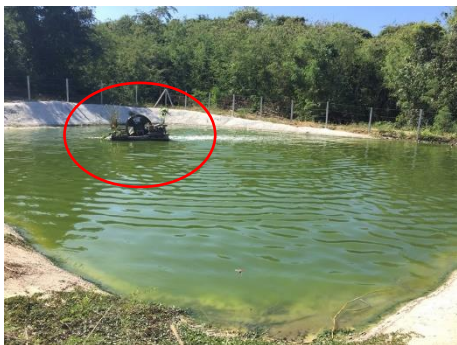
การติดตั้งเครื่องเติมอากาศ (Aerator) บริเวณบ่อพักน้ำสุดท้าย
