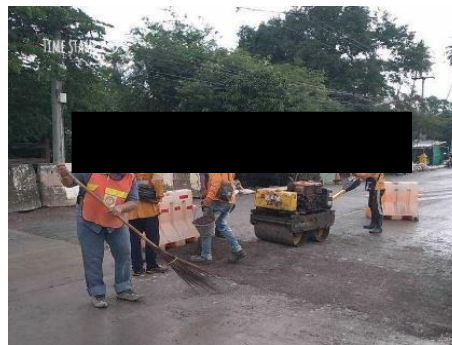
ภาพที่ 2.2-46 การซ่อมแซมถนนท้องถิ่นหรือถนนชุมชนที่ชำรุด
