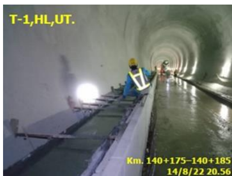
ภาพที่ 2.2-43 การติดตั้งไฟส่องสว่างในพื้นที่ปฏิบัติงาน
